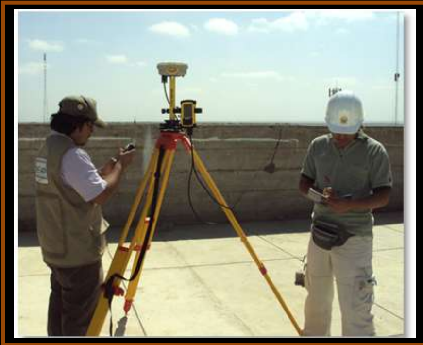
Enlace a Estación SIRGAS Piura (Marca IGN)
