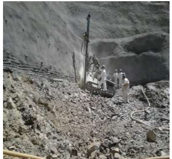
Perforación de taladros para voladura de cota 1485.00
