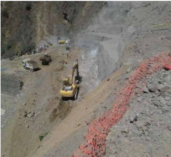
Corte y perfilado a nivel de cota
