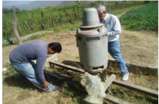
INSPECCIÓN TÉCNICA AL POZO D IRHS 38 EN EL SECTOR BIGOTE MORROPÓN, 27 DE AGOSTO DE 2013
