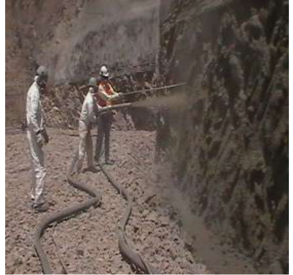
Lanzado de Shotcrete preventivo – Portal de salida
