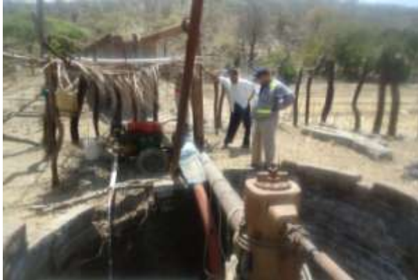
INSPECCIÓN TÉCNICA AL POZO DEL COMITÉ FARFÁN SECTOR YAPATERA – CHULUCANAS, 26 DE AGOSTO DE 2013
