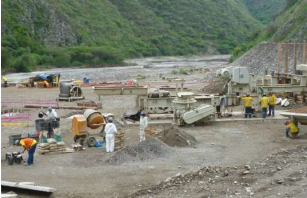
Plataforma Industrial donde se instalan las plantas de concreto y chancado de agregados y los talleres de metalmecánica y madera
