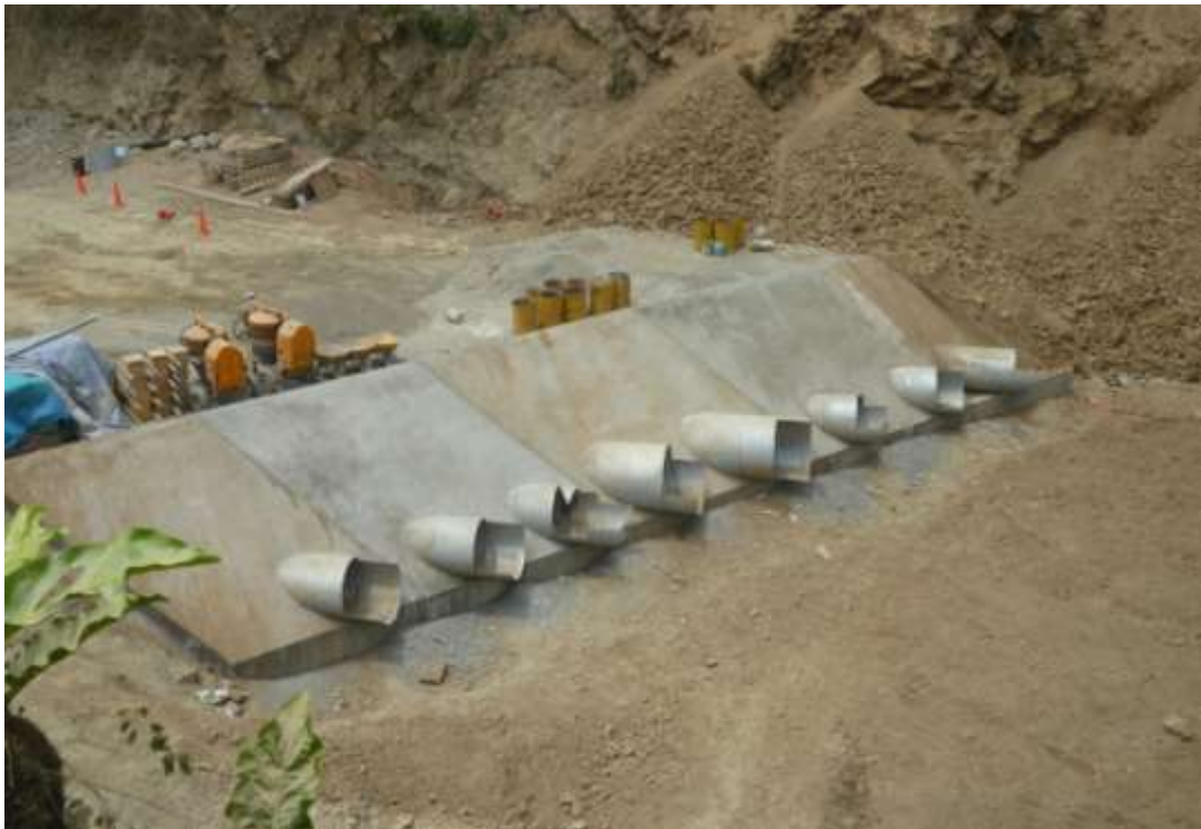
Preparación para el portal de salida
