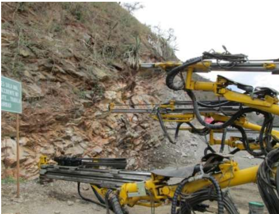
Maquinaria empleada para la perforación del túnel
