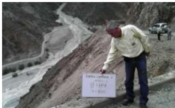
Muro de Contención: 17+789 a 17+810
