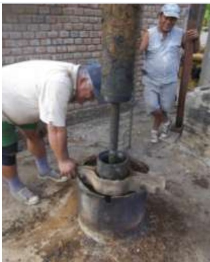
Desmontaje de equipo antiguo del pozo tubular
