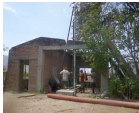
Instalación de equipo de aire comprimido
