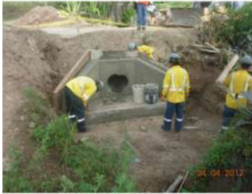
DESENCOFRADO DE ALCANTARILLA TCR KM 5+072
