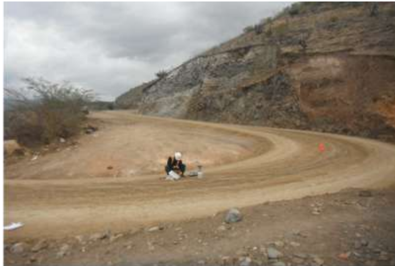
CONTROL DE COMPACTACION ALRELLENO COMPACTADO CON MATERIAL DE AFIRMADO KM 1+740
