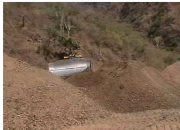
CANTERA SAONA (Preparación de Afirmado)
