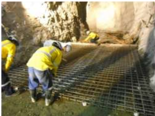
COLOCACION DE DOBLE MALLA PARA CONCRETADO DE LA SOLERA EN EL PISO DE LA GALERIA DE ACCESO
