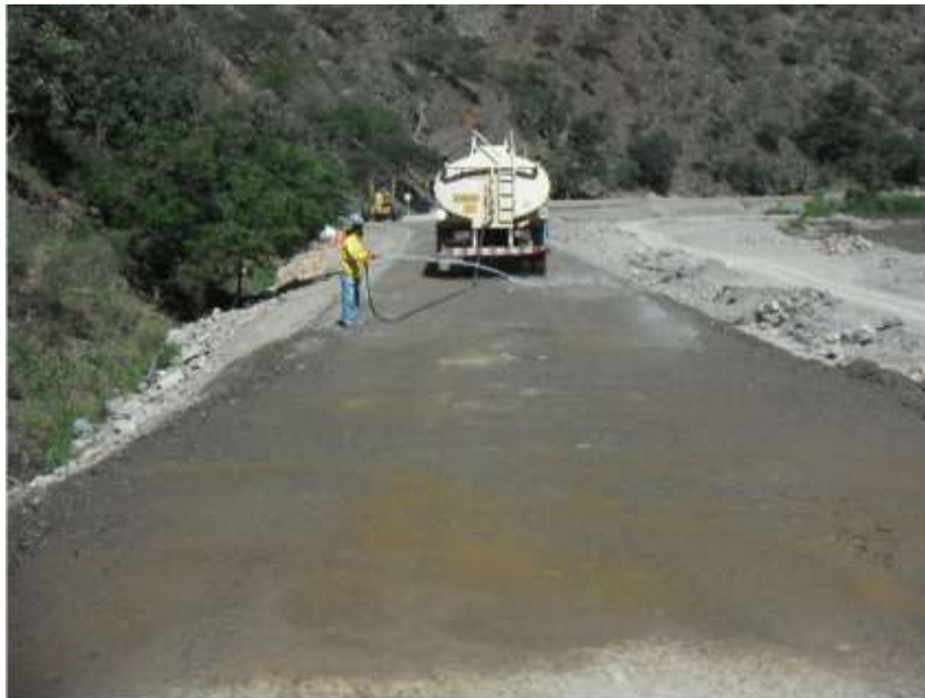
Construcción tramo PAMPAS – VENTANA 1 Km. 10+520 hasta Km. 24+125
