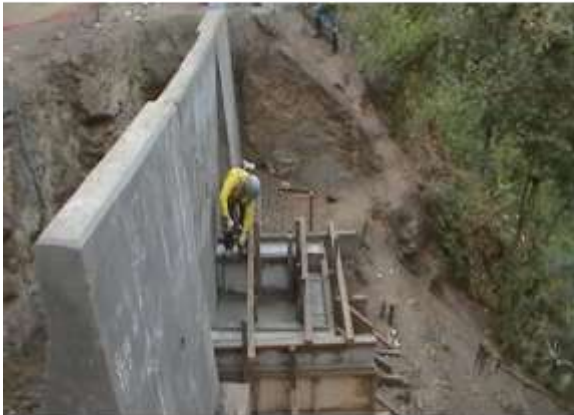
MURO DE CONTENCION Km.29+589 – 29+600
