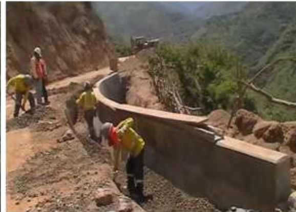
MURO DE CONTENCION km.35+740 – 35+760
