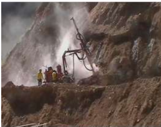
PERFORACION Y VOLADURA KM.7+400 – 7+420 EN ROCA FIJA
