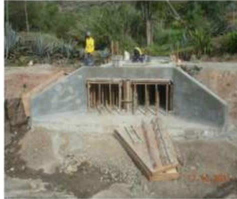
ALCANTARILLA MARCO DE CONCRETO KM 5+243
