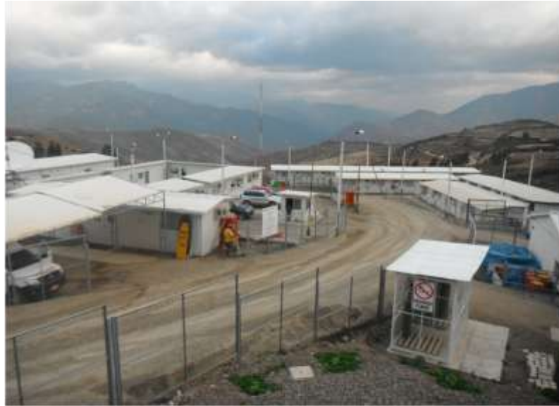
VISTA PANORAMICA DEL CAMPAMENTO PAMPAS UBICADO EN EL KM 10+200 DEL ACCESO SONDRILLO - PAMPAS
