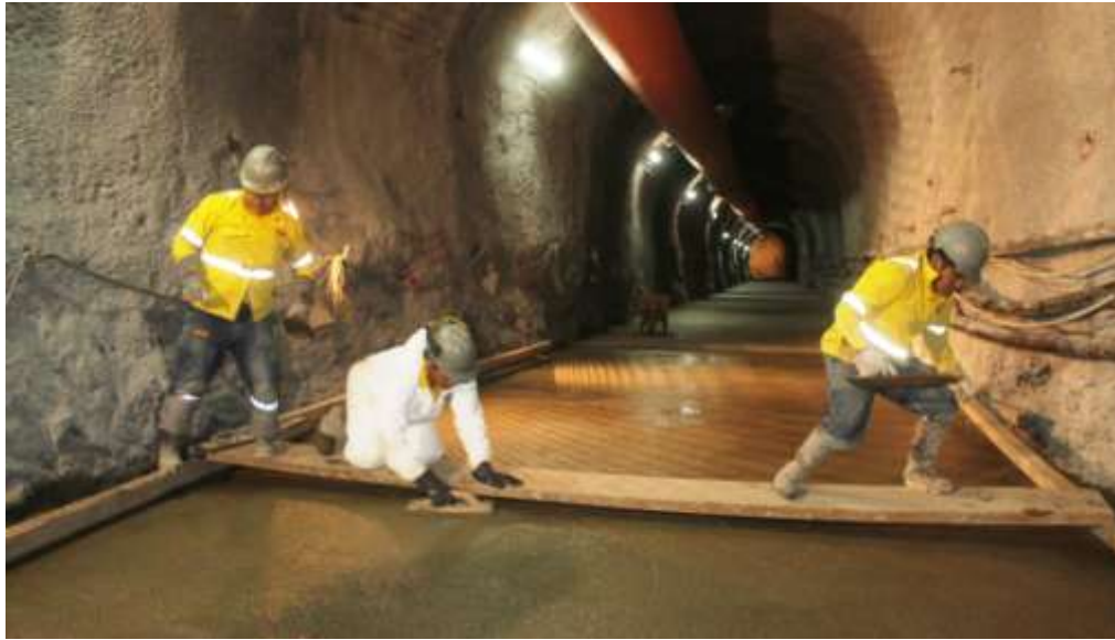
Trabajos de la solera del piso de la galería
