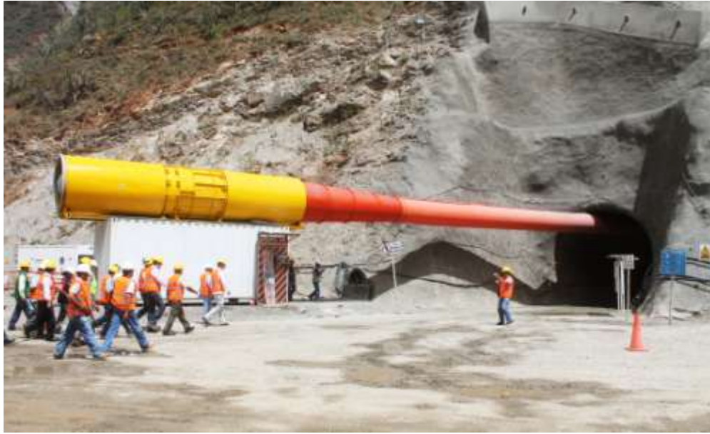
Vista del ingreso a la galería
