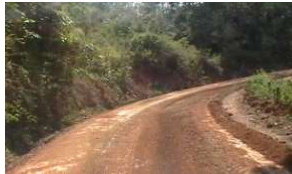
Km 18+120 – 18+300 Perfilado en Plataforma
