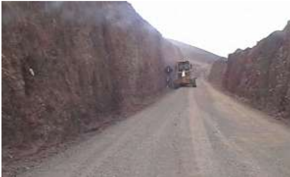
Km15+680 – 16+100 Limpieza de Cuneta
