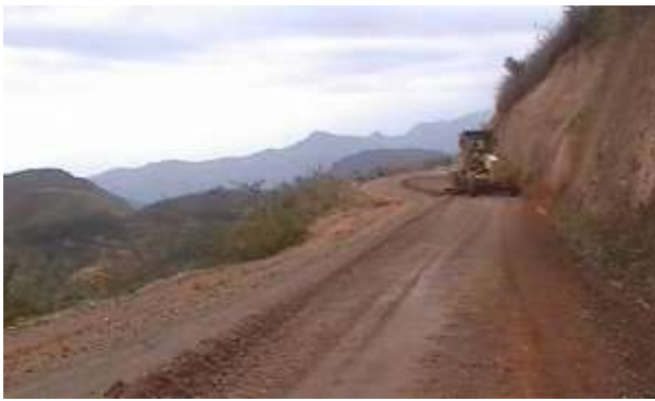
Km 19+200 – 19+450 Perfilado y Limpieza de Cunetas
