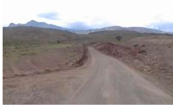
Km 12+820 – 13+300 Vista de la Limpieza
